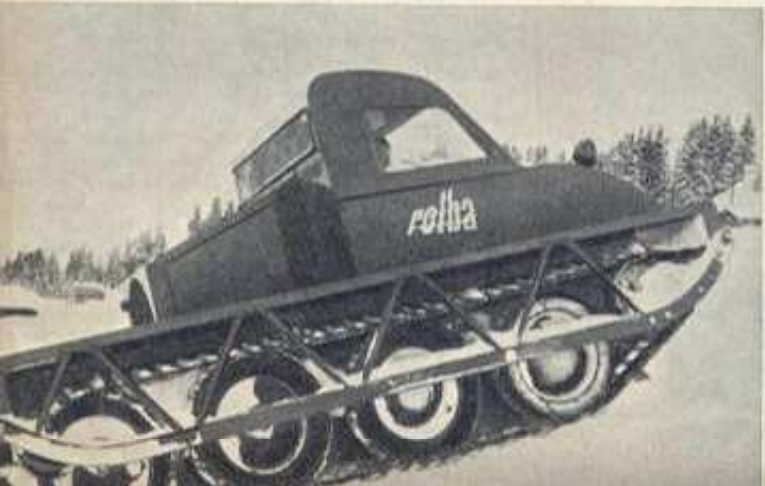
Le « Muskeg » Bombardier-Rolba M.63, modèle standard ne se différencie des autres que par l'emplacement du moteur et le nombre des roues.
