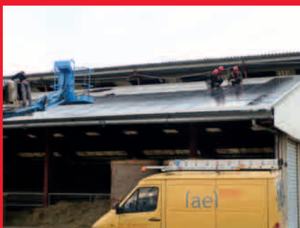
Installation des panneaux photovoltaïques sur le toit (596 m²) du centre d'allotement de Pamiers
