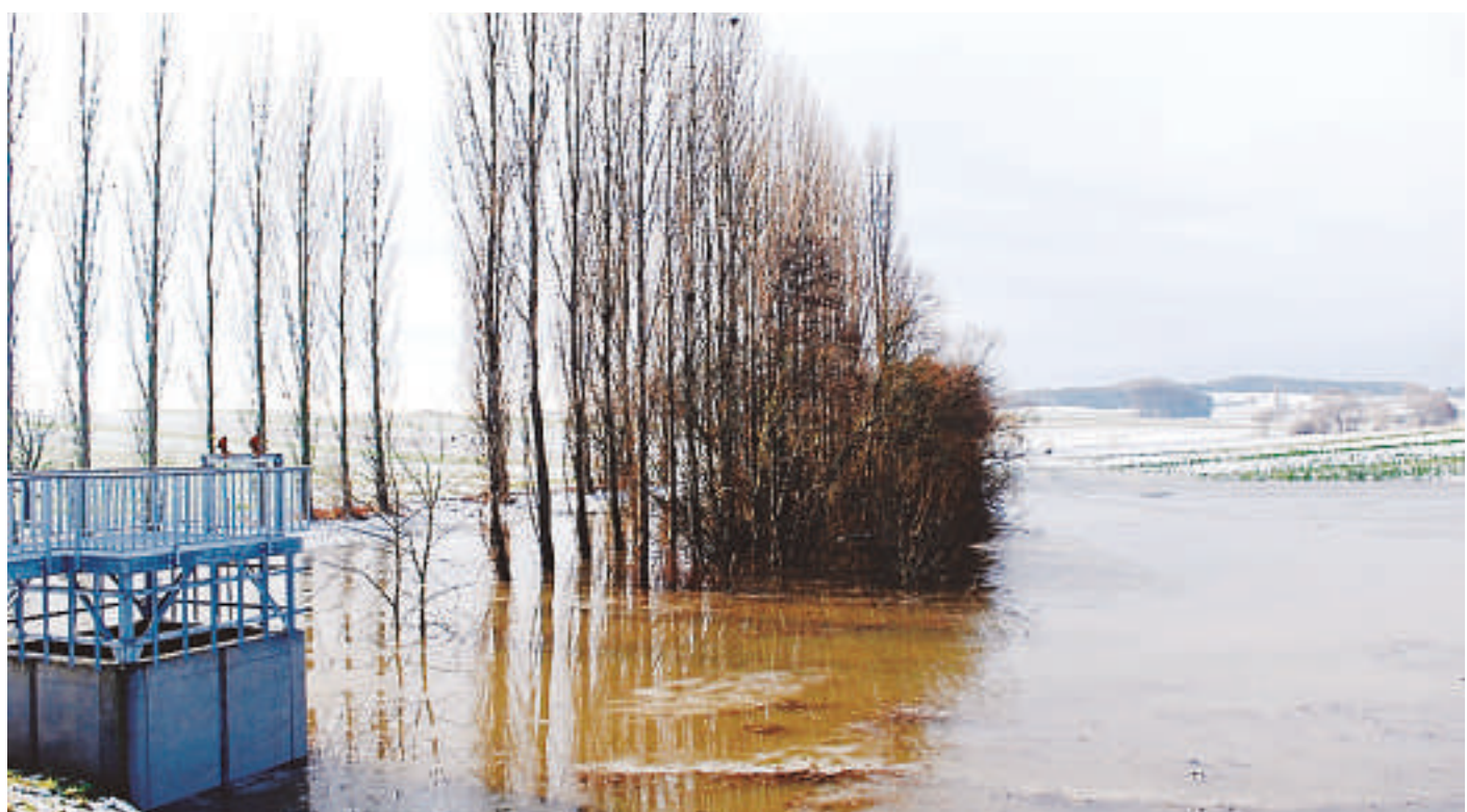
Au niveau de la digue, la hauteur d'eau avoisinait les sept mètres. (Photo DNA)
