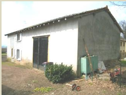
Avant la démolition
