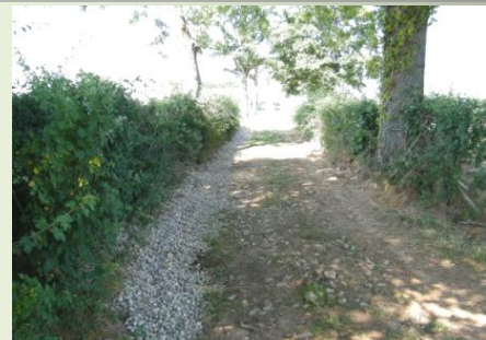
Réalisation d'un fossé Pose d'un drain et galets
