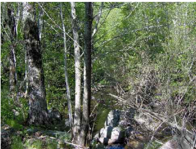
Le Crouzoulous / avant travaux
