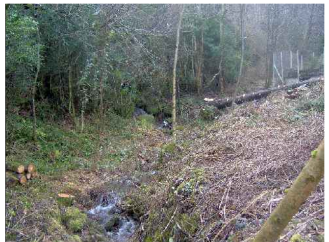
Le ruisseau des Fournels / après travaux
