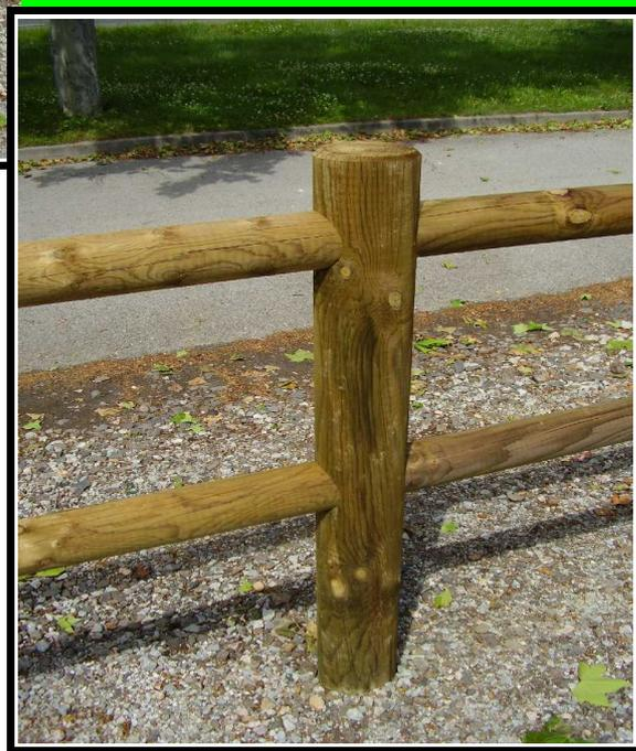
Diamètre des appuis 14cm Long,1,50m à sceller de 40cm dans le sol pour une hauteur de 1,10/1,15m
