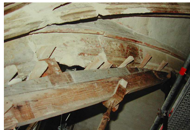
Mise sur cintre des claveaux brisés
