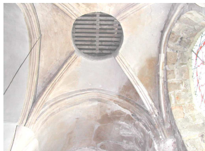
Voûtes d'ogives du rez-de-chaussée du clocher
