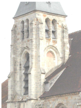
Façade Sud du clocher
