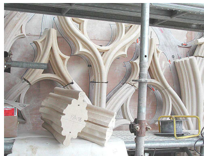
Remplacement, en cours, de fourches du remplage
