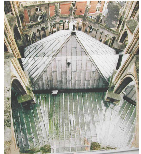
Toiture en plomb de la travée 2N - 3N
