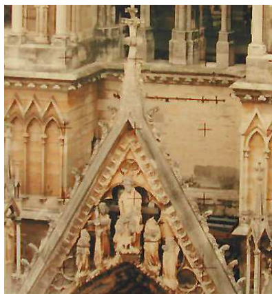
Grand gâble, avant travaux
