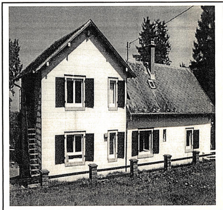
Le refuge du HOHBUHL
